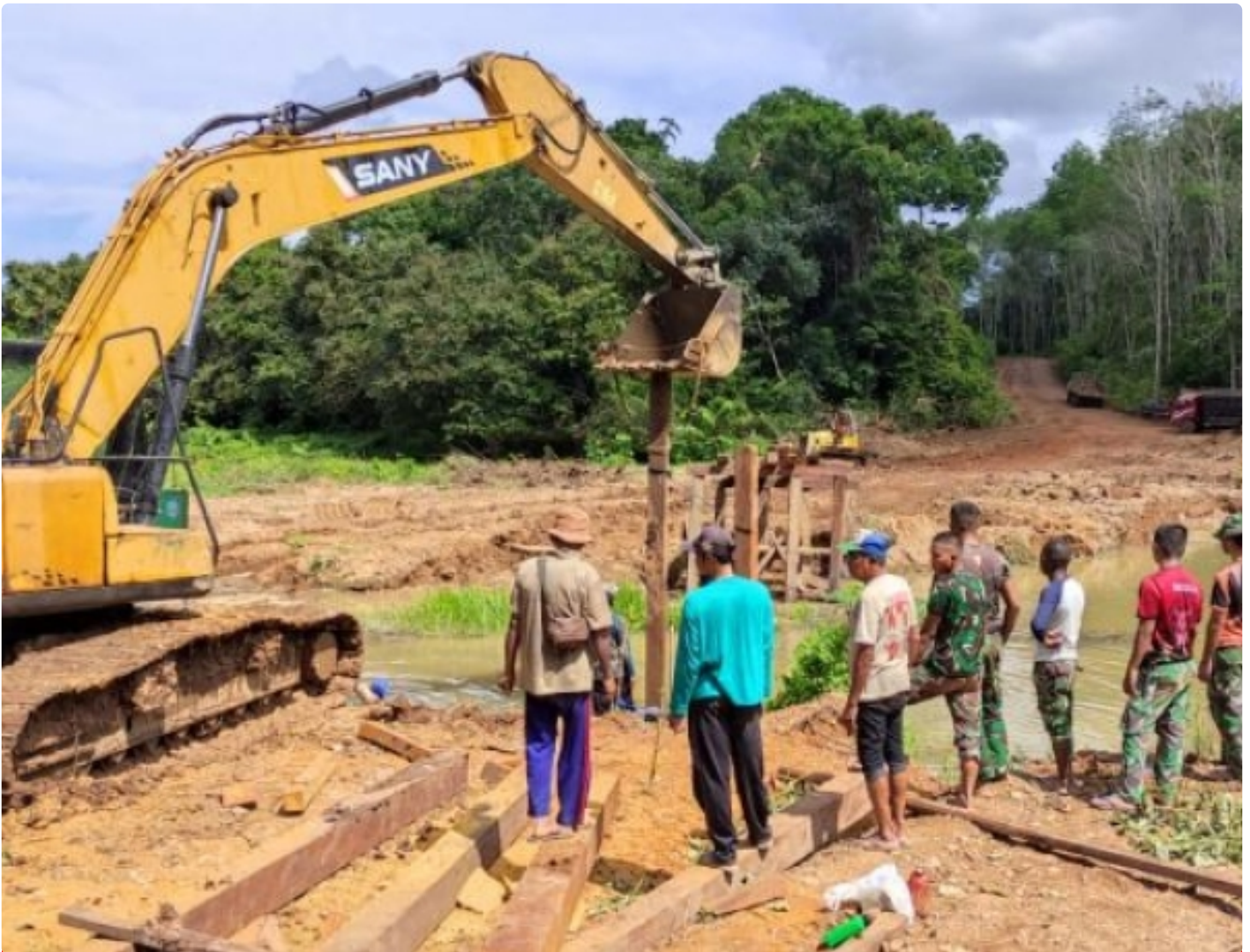
Pemsangan tiga Pancang Jembatan Dibantu Alat Berat
