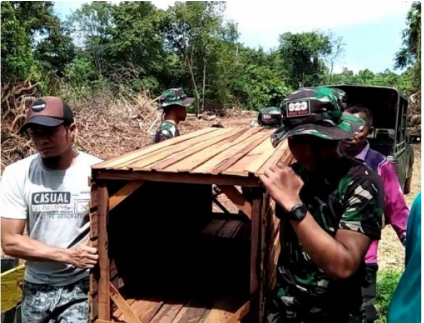
Anggota Satgas TMMD Angkut Material Untuk WC
